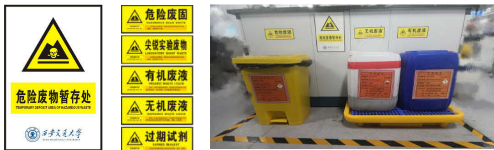
图 21 危废暂存区统一标识及存放示例
